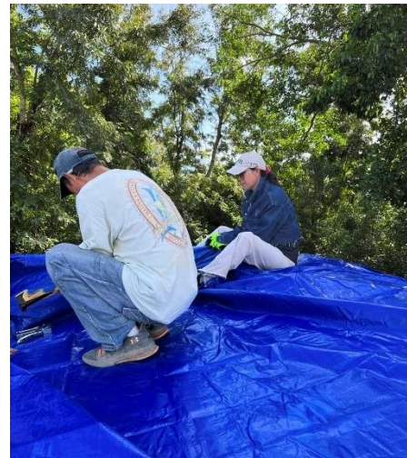
사진 59. 허리케인 피해 지붕 보수
